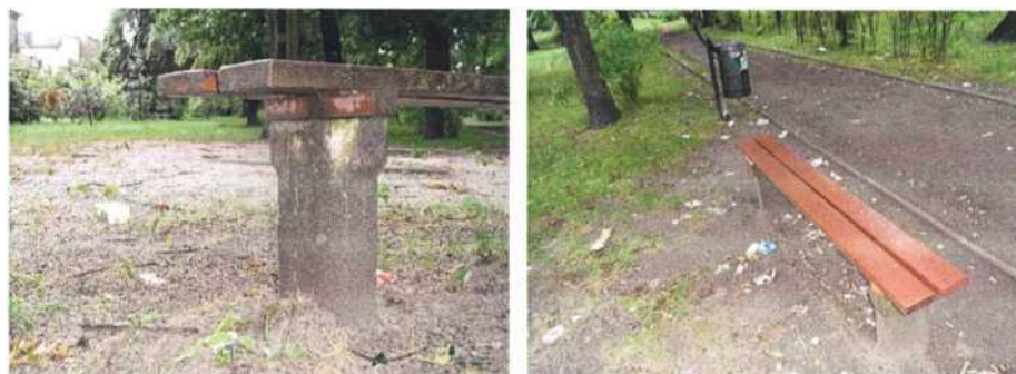
Stare i bardzo stare ławki, wszechobecne śmieci. Fot. K. Słezionka, portal Nasze Miasto
