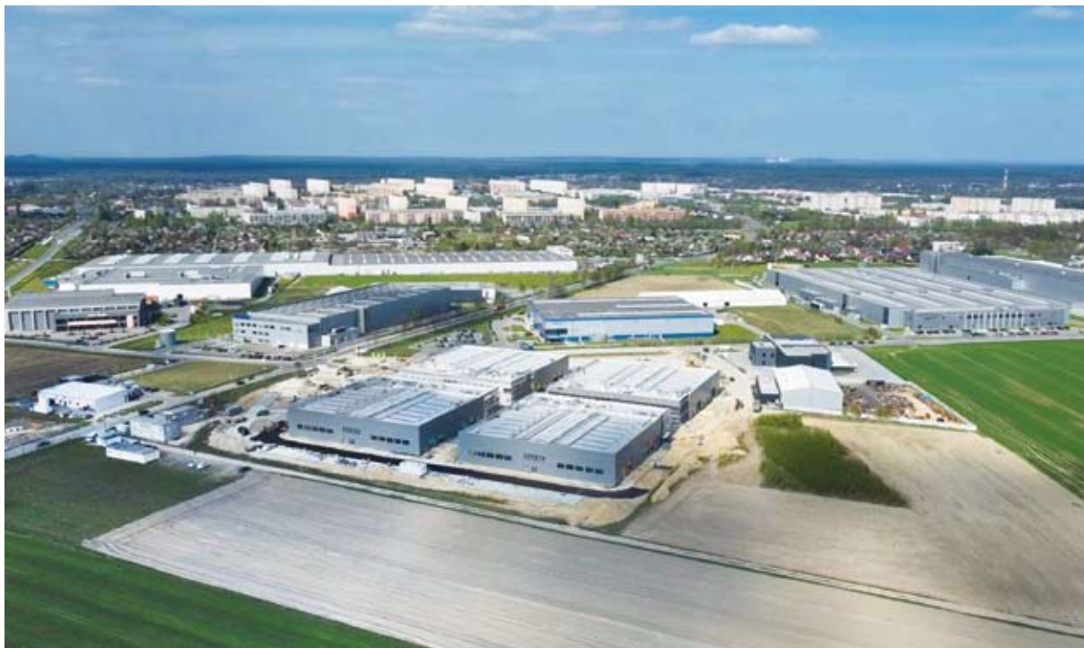
Akcelerator biznesowy KSENON w budowie w tle tereny KSSE
