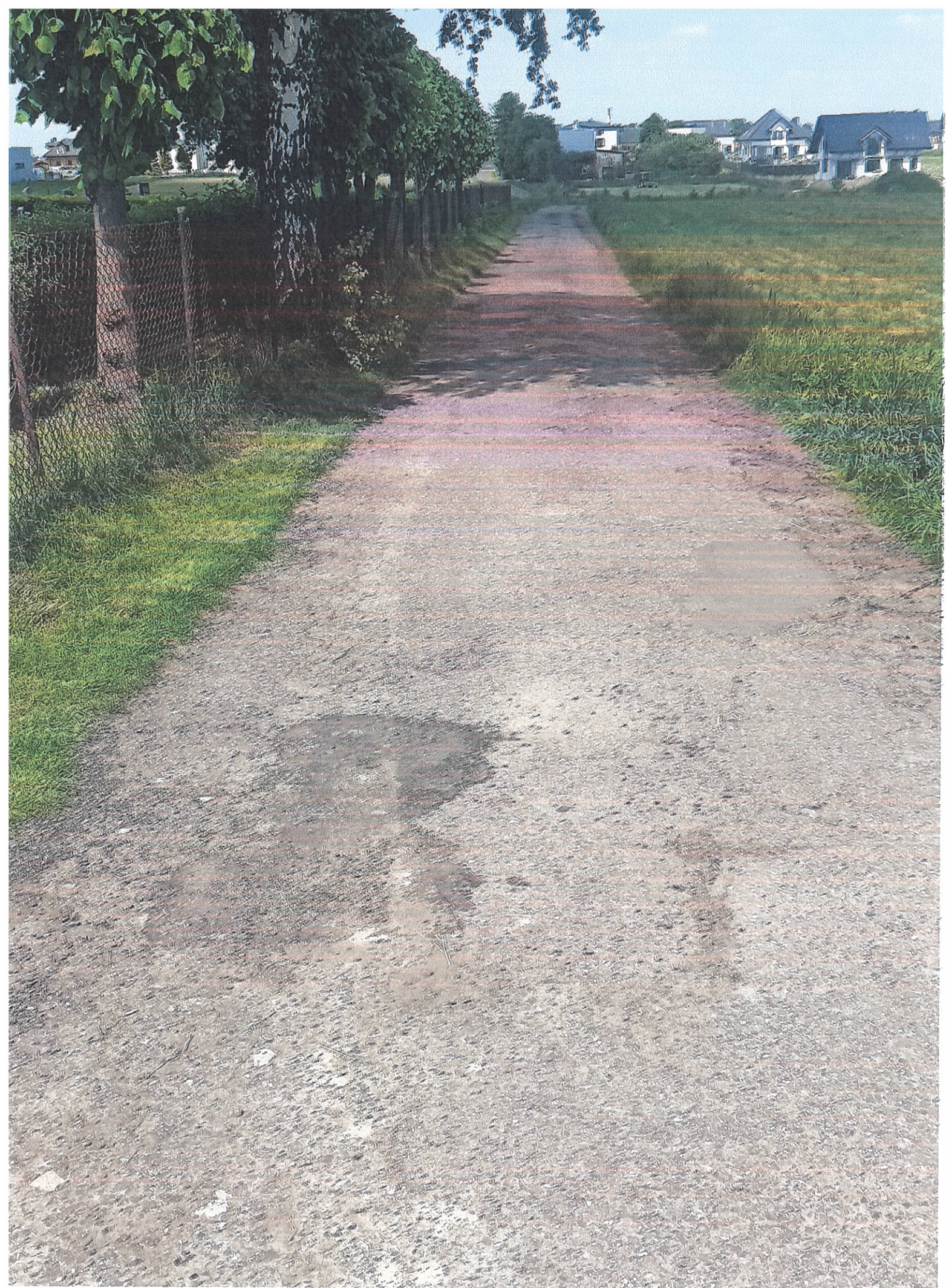
OSINY reuert tgerikke drogi od Wiseney do Wesołuchnej
